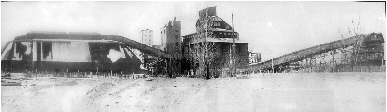
Рисунок 8 – Елеватор «Мастодонт»: зліва – зерновий склад, у центрі – робоча будівля з обладнанням, зправа – відпускна повітряна галерея на річковий транспорт
