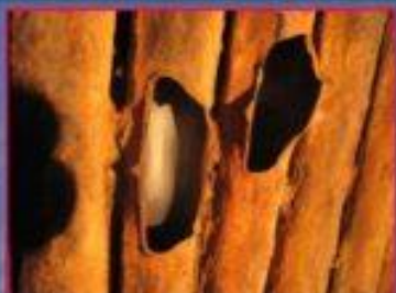
Розрив труб радіаційної поверхні пилувугільного котла, що спричинений абразивним зносом металу
