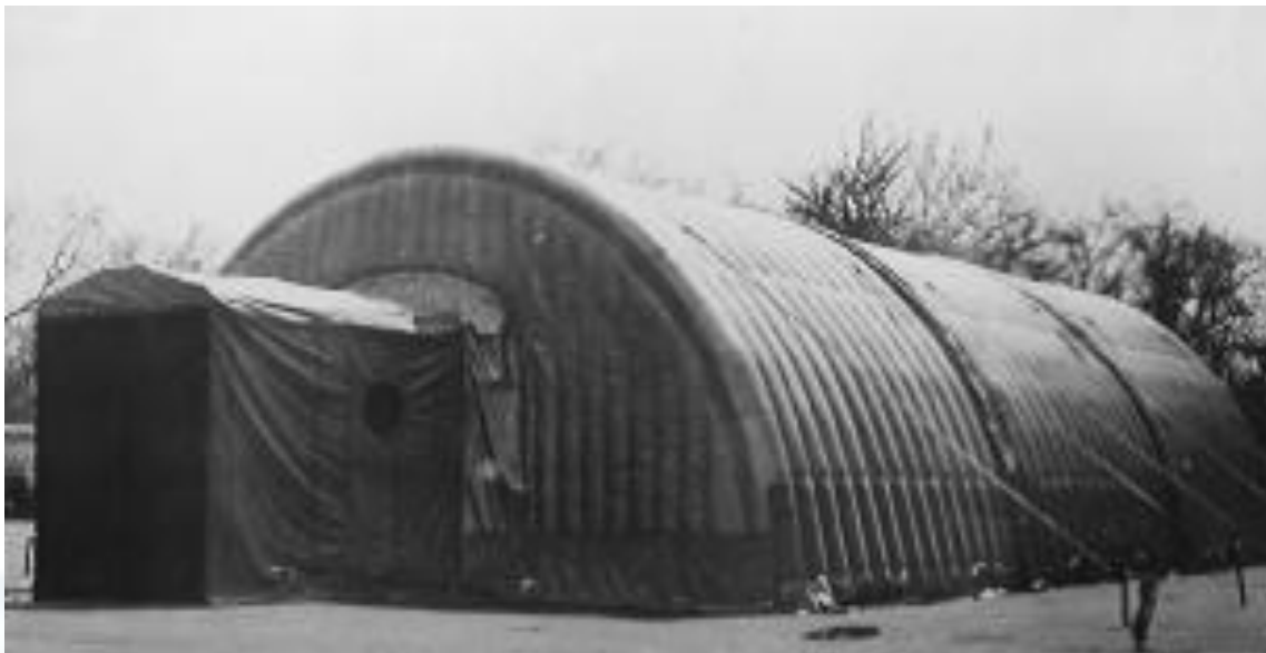
Фото 15. Пересувна холодильна установка ФХ – 80П
